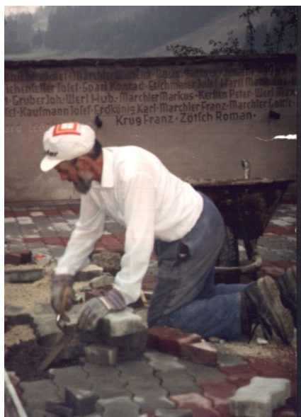
Fritz Dokter verlegt den Boden
